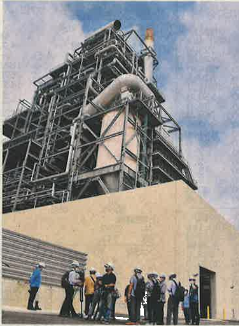
報道陣に公開された中城バイオマス発電所
